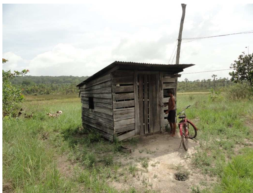
Figura 26 - Usina do Gerador
